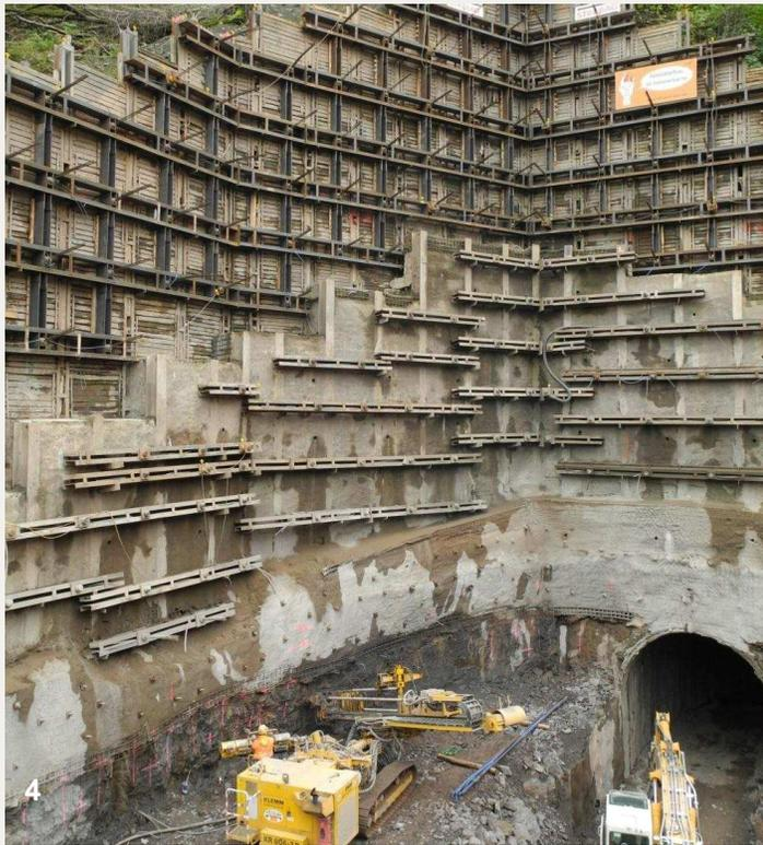
1 Montabaur: Spritzbeton und Ankerarbeiten;
